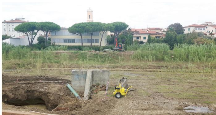
**Fig.2: Il basamento del traliccio travolto dalla piena dell'Ardenza**
