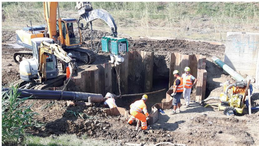
*Fig.4: Il punto di inserimento della condotta da infiggere con TOC*
